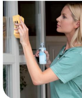
Die Pflegemilch schützt die Holzbauteile nicht nur, sondern verschleißt auch die mikroföinen Risse, die zum Beispiel beim Aufschlag von Hagelkörnern entstehen können. Sie wird mit dem Schwamm gleichmäßig aufgetragen.
